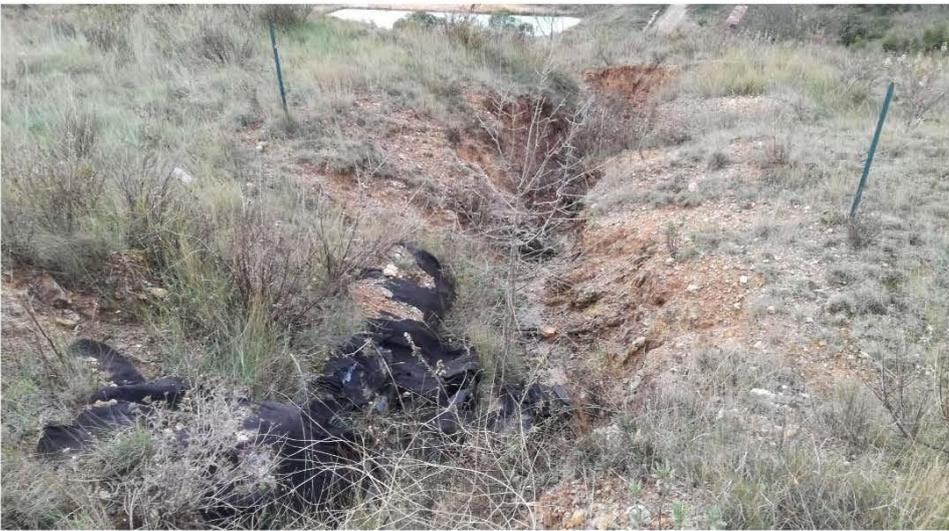
Point d'observation 12: zone d'évacuation de la buse de sortie du bassin (forte érosion)
