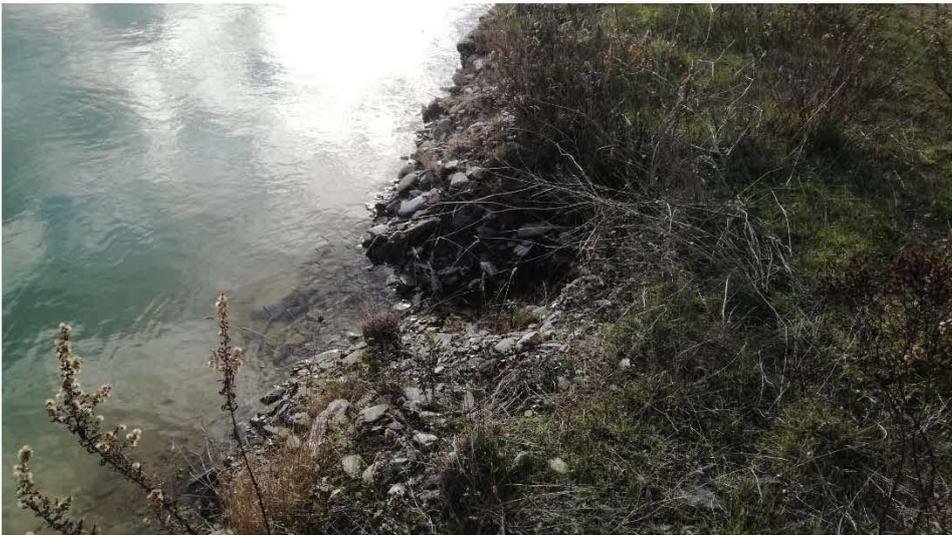
Point d'observation 8 : 4 zones d'érosion décimétriques sur la digue entre les bassins 3 et 4 observées en 2018 n'ont pas évoluées en 2020
