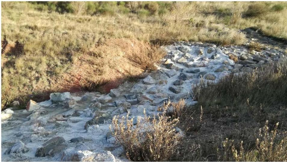
Point d'observation 6: Reprise par enrochement bétonné des ravines en amont du bassin
