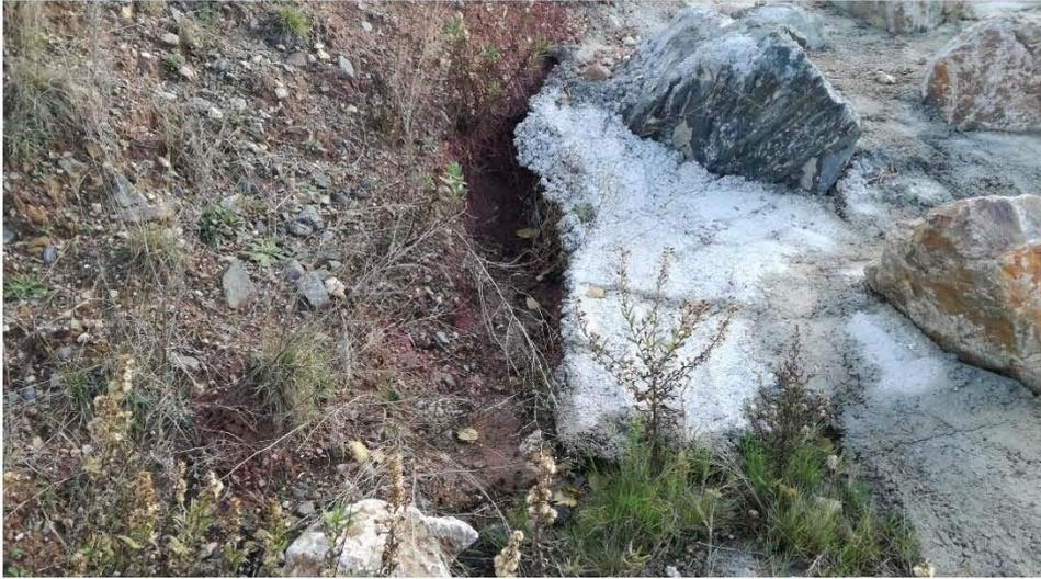
Point d'observation 6 : début d'érosion en bordure de l'enrochement bétonné
