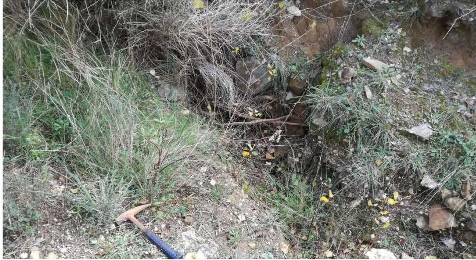
Point d'observation 14/33 : Mise à nu des résidus miniers après érosion de la couverture (2013/2014) partiellement traités avec des enrochements bétonnés dont l'extrémité aval se délite (2015) et mise à nu des résidus miniers (continuation des phénomènes d'érosion)
