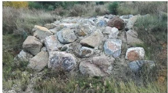
Point d'observation 3 : Venue d'eau sur talus avec zone d'érosion (2012/2014) stabilisée par enrochements bétonnés en 2015 sans évolution en 2020
